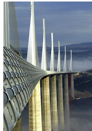
VIADUC DE MILLAU
