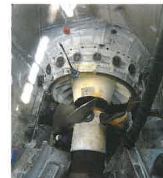
Rénovation du groupe de production n° 2
