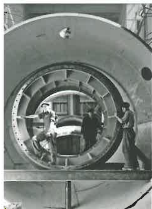
Construction du barrage (1954-1957)
