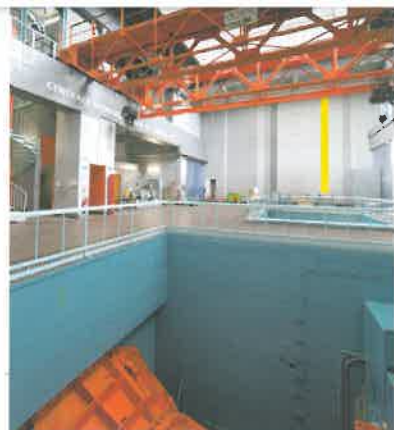
Salle des machines
