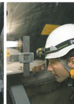
Surveillance du barrage à l'aide d'un pendule
