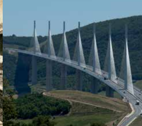
Le viaduc élevé par Norman Foster et Michel Virlogeux, entre 2001 et 2004, permet de franchir la vallée du Tarn entre le Causse Rouge et le Causse du Larzac, reliant Paris à Barcelone par l'A75.
