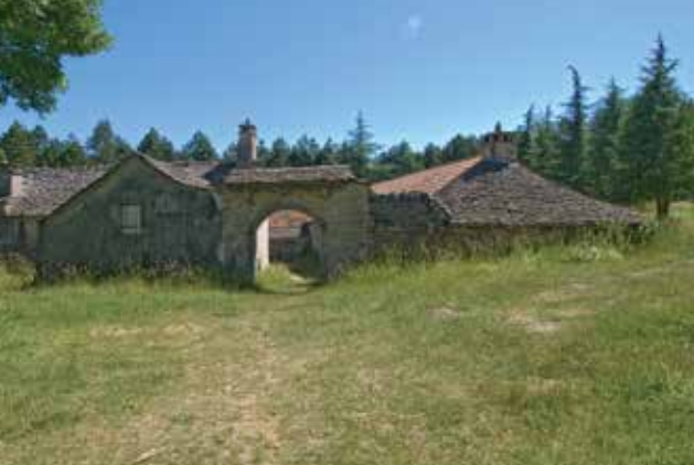
La ferme des Cades se compose, autour d'une cour, d'une maison, de deux longues bergeries voûtées dont l'une s'achève par le fournil à la toiture de lauzes de calcaire.
