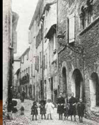
Cette maison médiévale du 55 rue Peyrollerie a perdu baie géminée et cordon décoratif mais conserve les grandes arcades de boutique du rez-de-chaussée.
