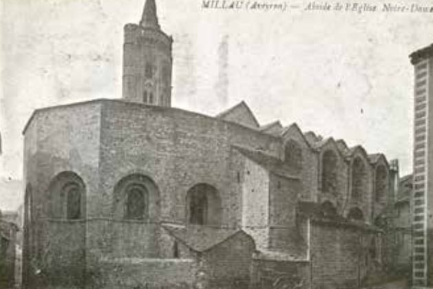
Le chevet polygonal de l'église et son élévation nord contre laquelle on perçoit les chapelles ajoutées, puis détruites, aux XIX e -XX e siècles.
