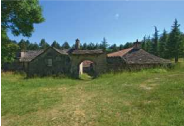
La granja de Cades está construida alrededor de un patio. Se compone de una casa, de dos grandes establos abovedados, uno de los cuales termina con un horno cuyo tejado está compuesto de tejas de pizarra calcáreas.
