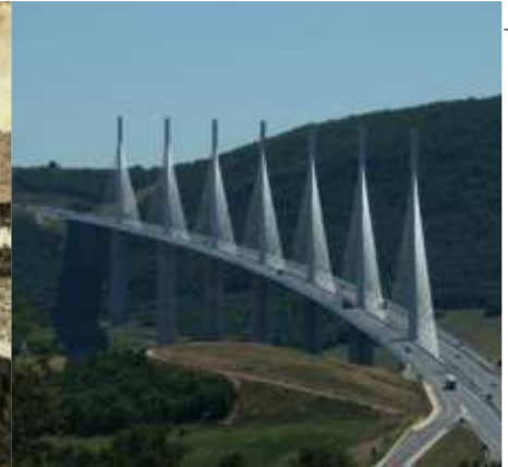
El Viaducto elevado por Norman Foster y Michel Virlogeux entre 2001 y 2004, permite franquear el valle del Tarn entre la Meseta calcárea Roja y la Meseta calcárea del Larzac uniendo así París a Barcelona por la A 75.
